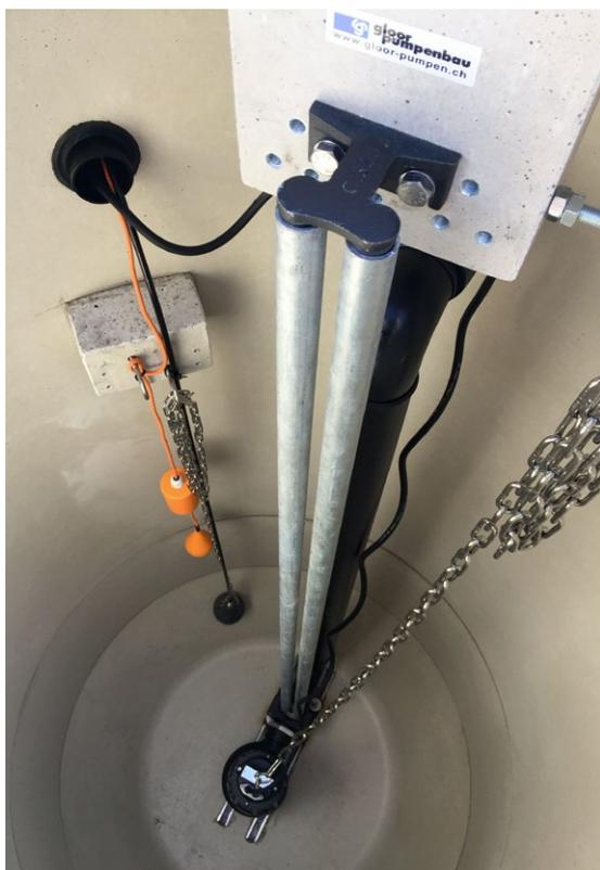
Fosse de pompage étanche et résistante aux eaux usées, en béton polymère. Exécution en tant que station de pompage simple ou double.
