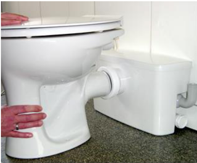
(Abb. 1) Stellen Sie das WC vor die Kunststoffbox und schieben Sie den WC-Stutzen in die Verbindungsmanchette der Anlage. Achten Sie unbedingt darauf, dass der Behälter der SEKAMTIK 10E 6M nicht eingedrückt wird.
